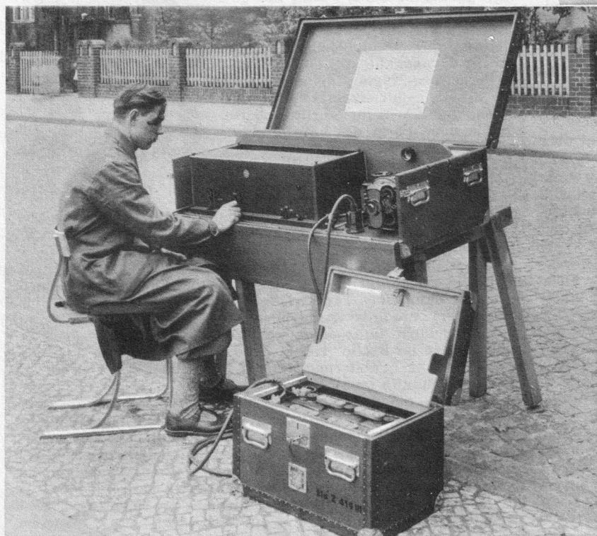
Unten: Der Betrieb der ganzen Anlage erfolgt aus einem Bleiakкумуляtor, der in einem kleinen, von zwei Männern leicht zu tragenden Koffer untergebracht ist. (Sämtliche Aufnahmen Telefunken)
